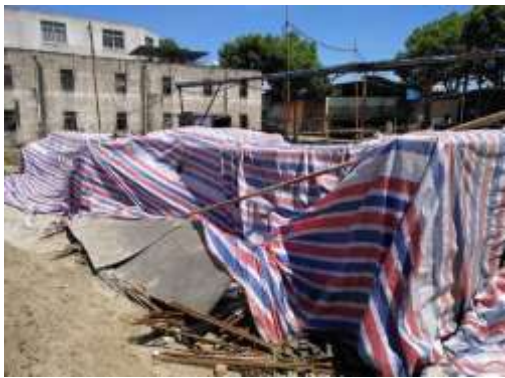
固化污泥篷布覆盖
