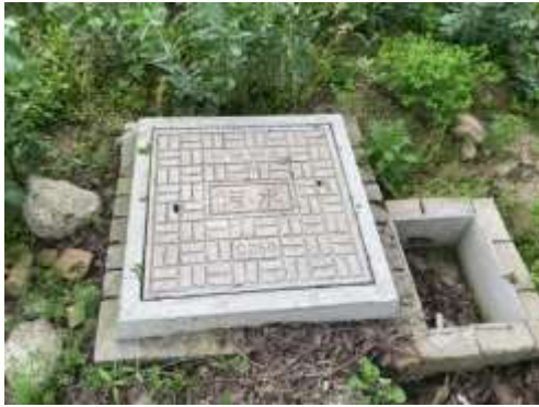
锡北运河6m节制闸化粪池
