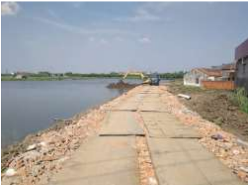
施工道路临时道路铺设钢板
