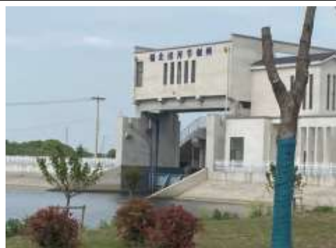
24.锡北运河枢纽（锡北运河支河口门建筑物）
