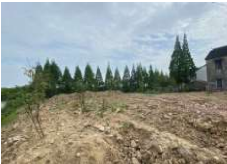
大圩浜涵土方周转场
