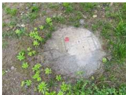
卫浜枢纽管理所化粪池
