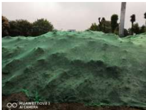
回填土方集中堆放
