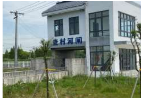
20.查村河节制闸
