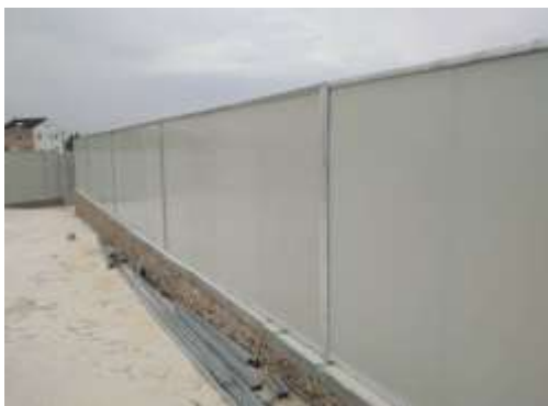
施工现场围挡
