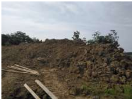
珠桥河排涝泵站土方周转场
