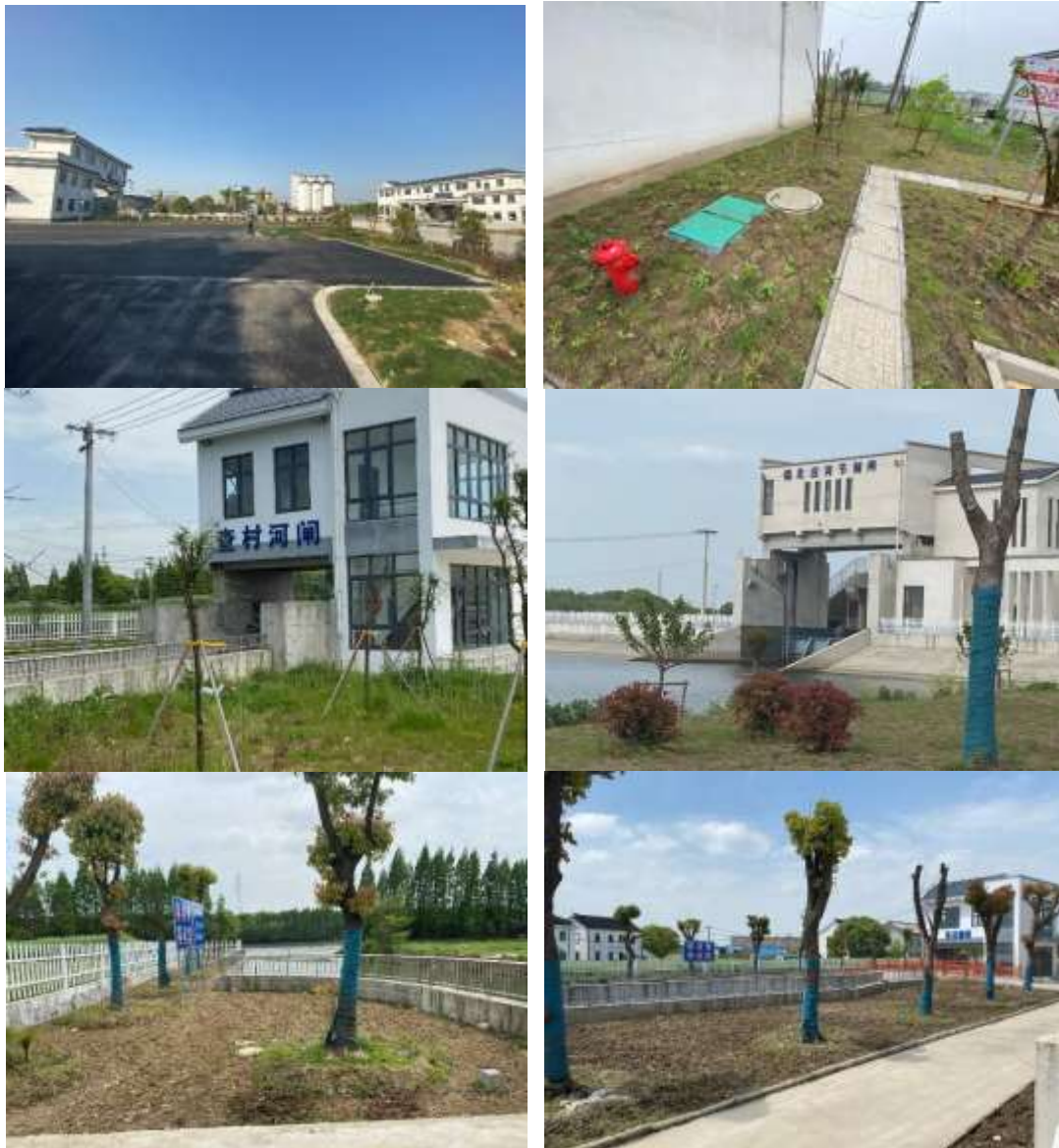
图6.1-1 主体工程区植被恢复现状
