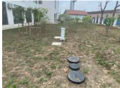
锡北运河套闸化粪池
