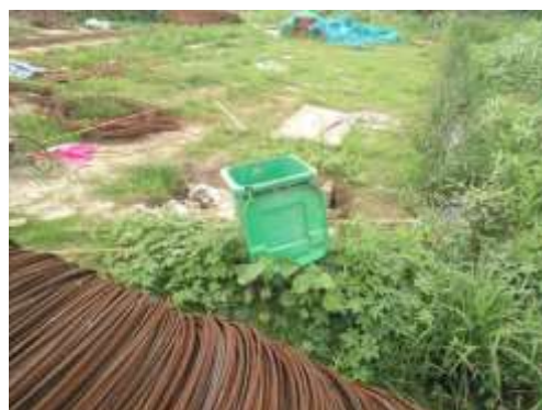
施工现场生活垃圾收集
