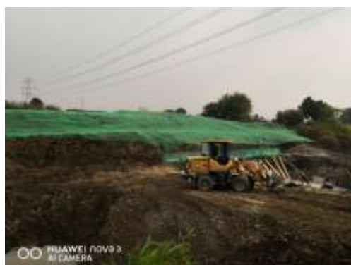
弃土区边坡压实防护
