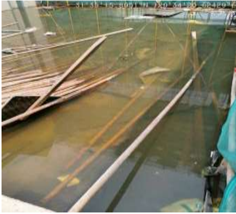
图 5.2-1 卫滨枢纽施工废水监测取样处
