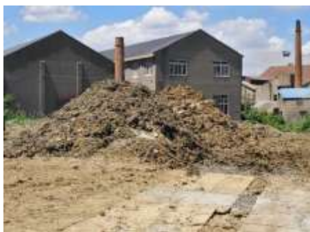
丰泾河泵闸土方周转场
