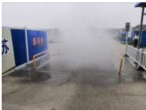
常熟境内工地出入口洗车平台
