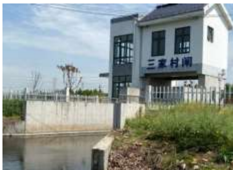
19.三家村河节制闸
