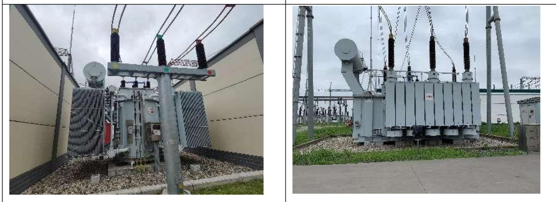
#5 主变 4 号低压电抗器及防火墙
