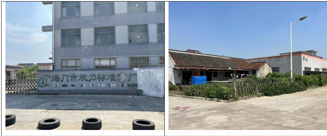
图 3.33 德胜工业园内现状厂房
