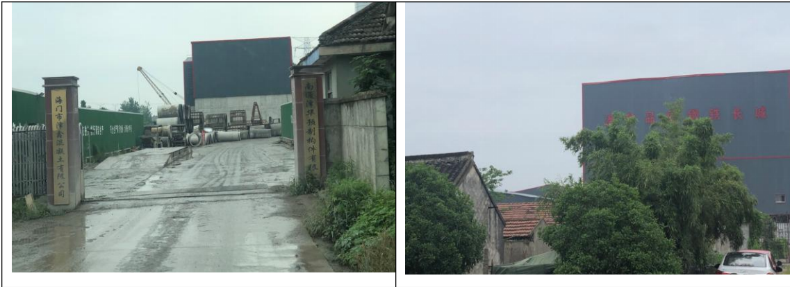
图 3.32 北方方案通启运河南岸涉及的大量厂房
