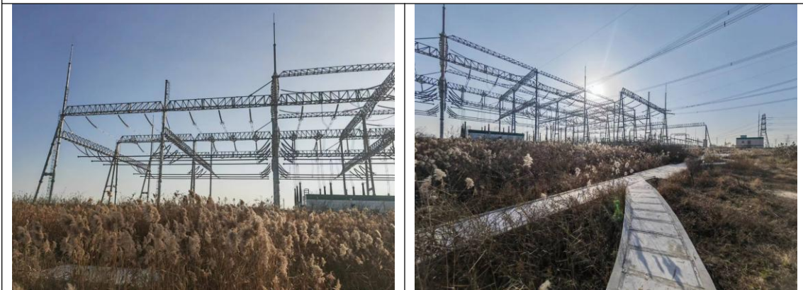
本期变电站扩建500kV出线间隔位置
