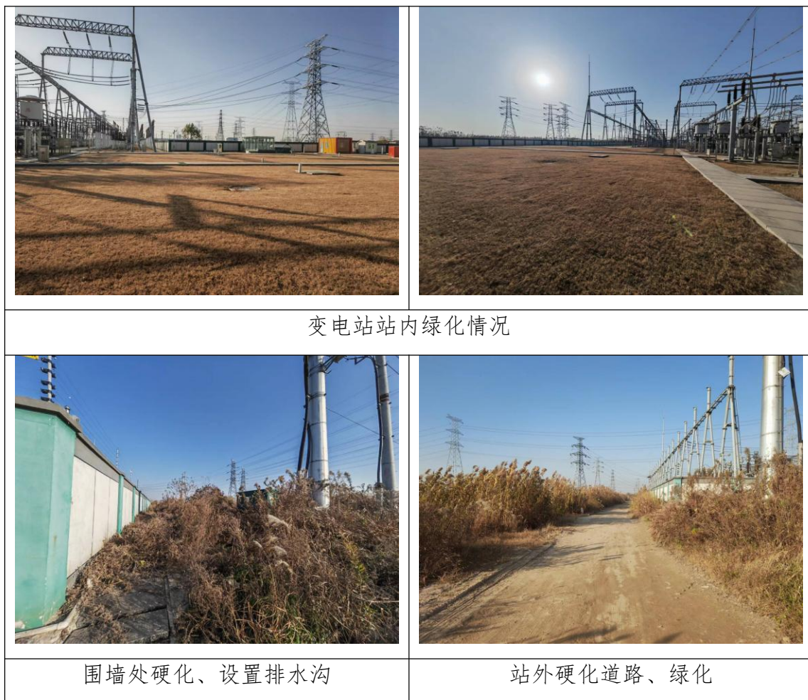
图 3.8 变电站采取生态保护措施
