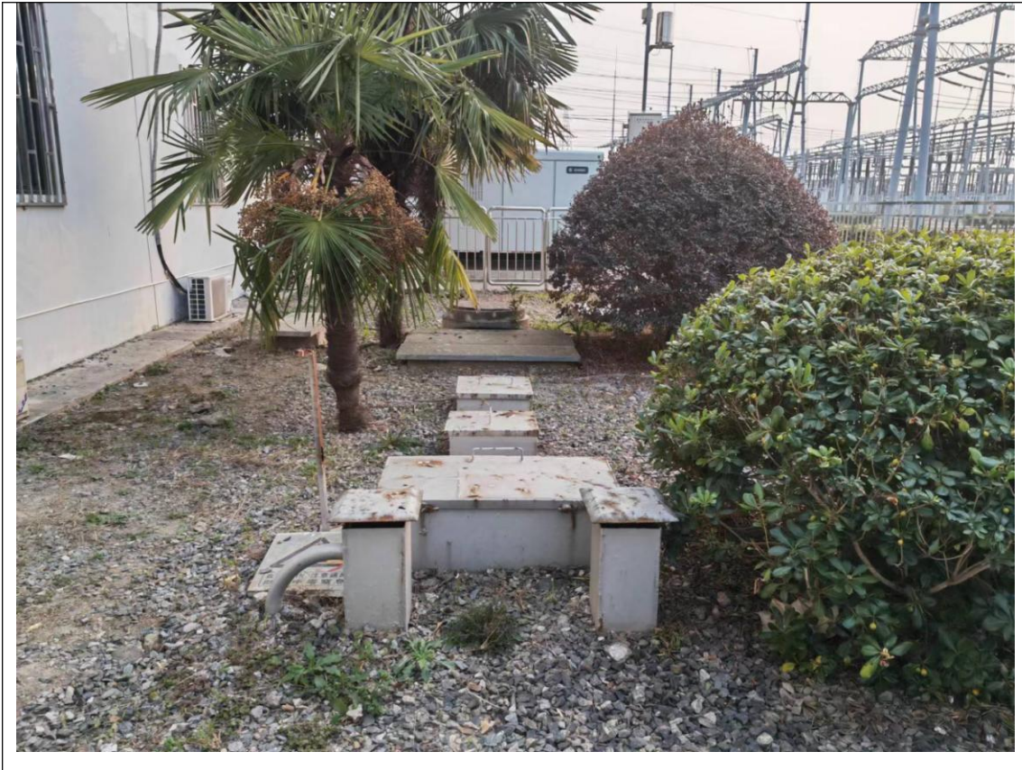
图 3.18 变电站原有地埋式污水处理装置
