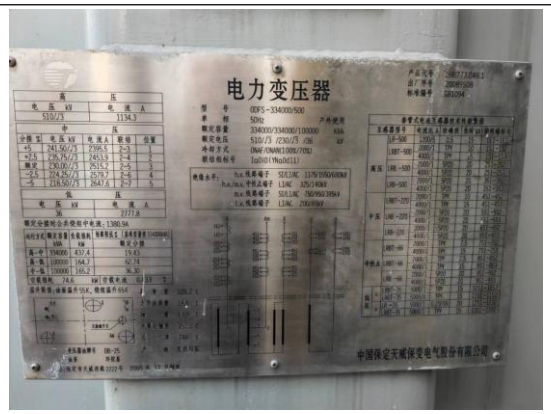
变电站#3 主变压器油量 69.9t
