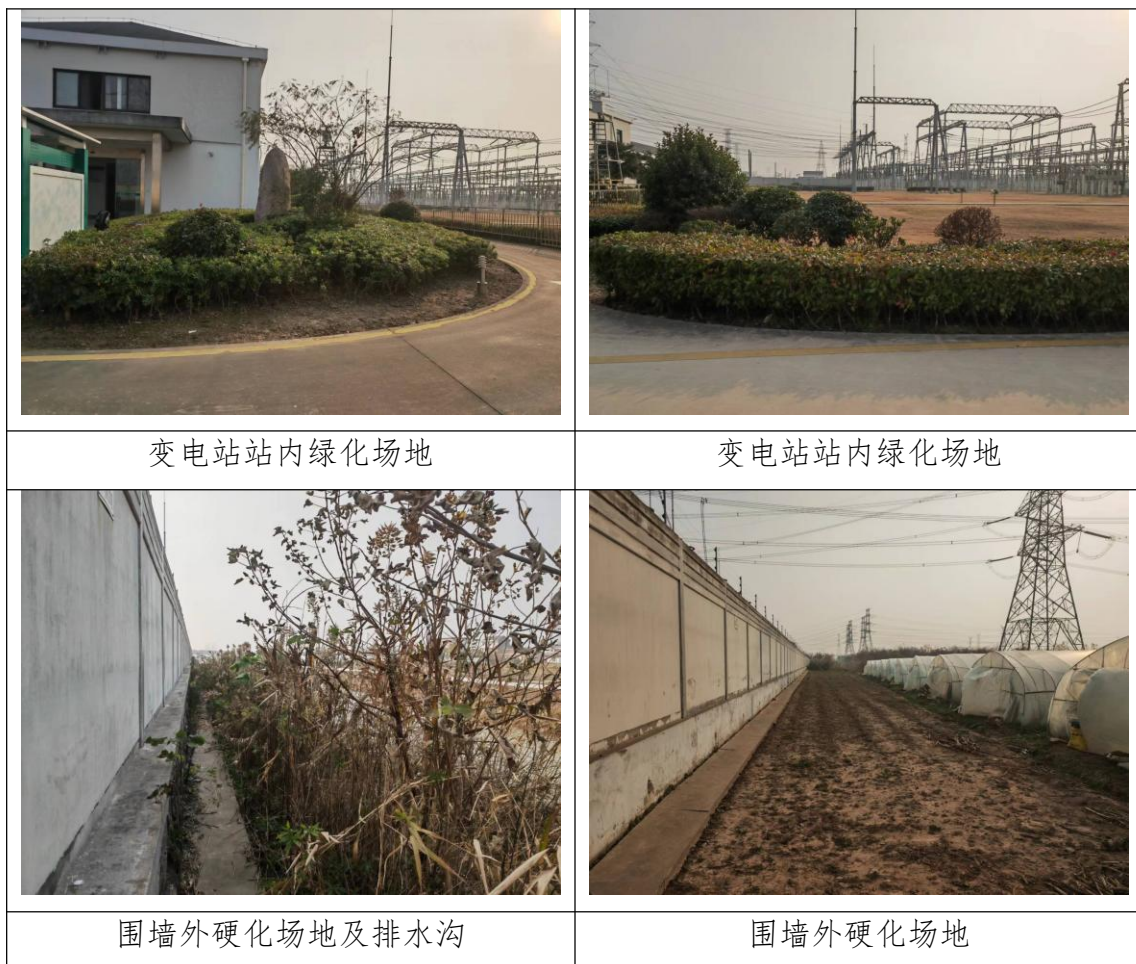
图 3.16 变电站采取生态防治措施
