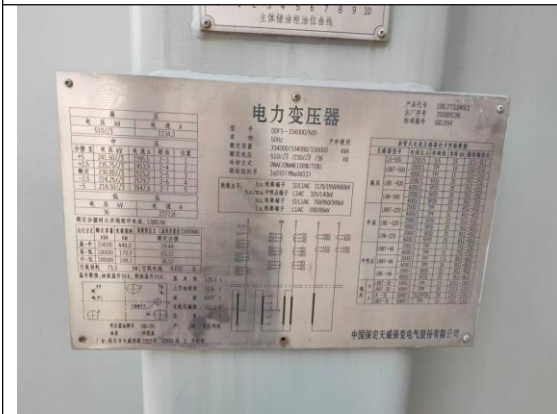
变电站#2 主变压器油量 69.9t
