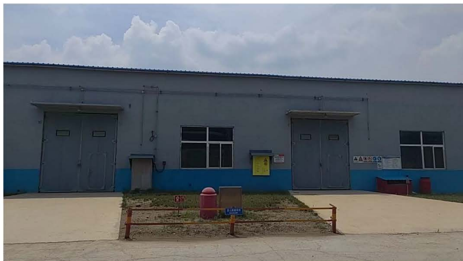
图 3.1.4-1 1#危废仓库现场照片
