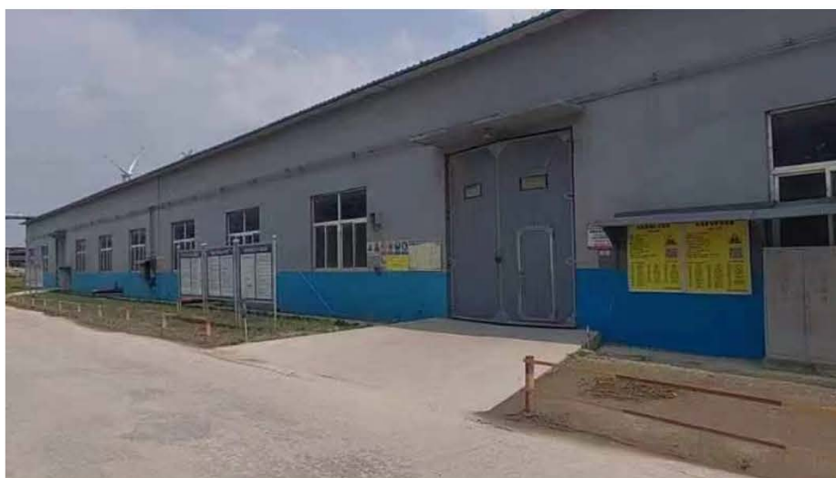
图 3.1.4-2 2#危废仓库现场照片
