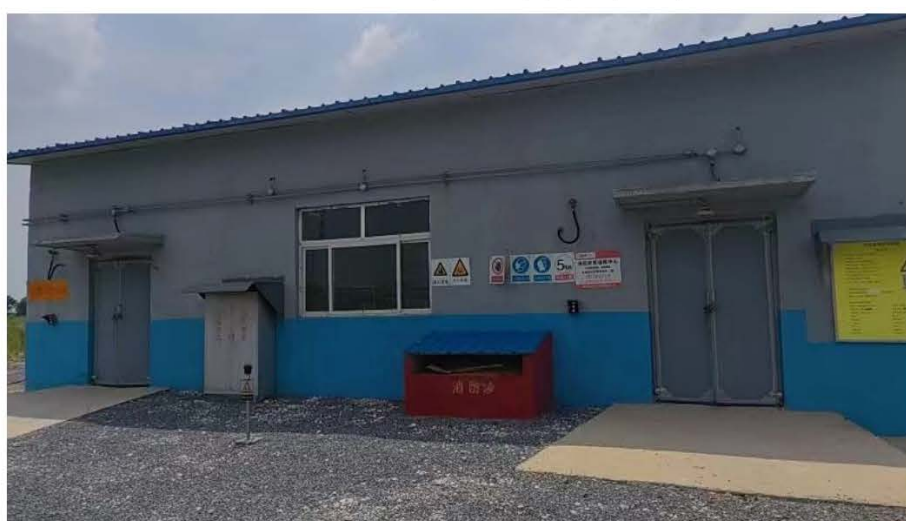
图 3.1.4-3 3#危废仓库现场照片
