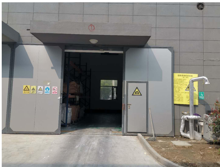
图 3.2-26 危废仓库外部图
