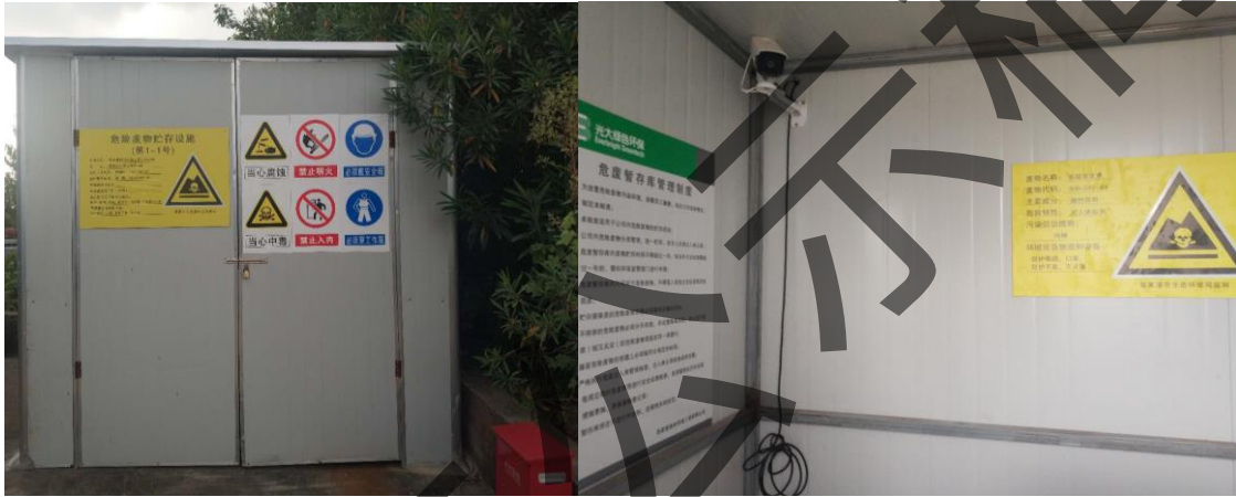
图 3.6.1-1 危废暂存库照片
