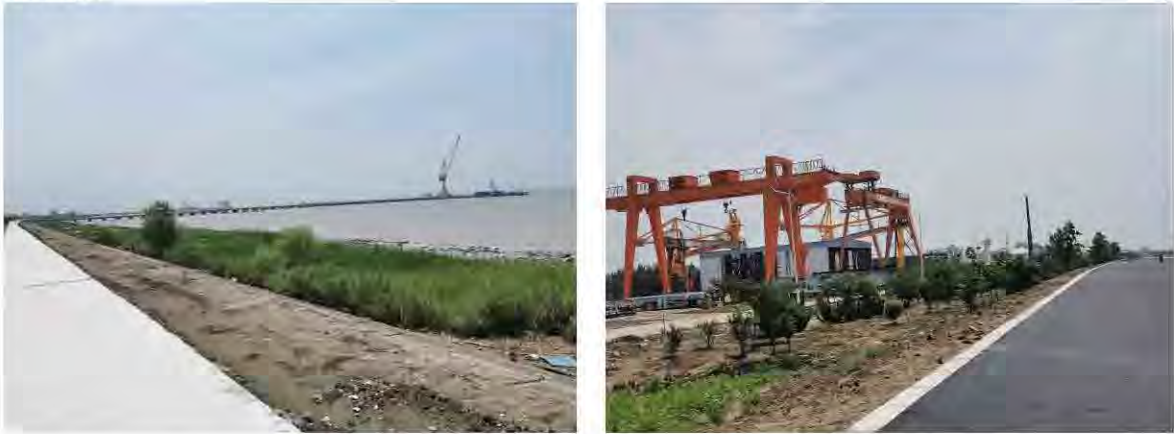
图 3.2-18 海门市沿江堤防生态公益林现场图片
