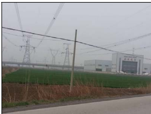
图 3.11 本工程新建 500kV 线路附近的新迪建材周围情况
