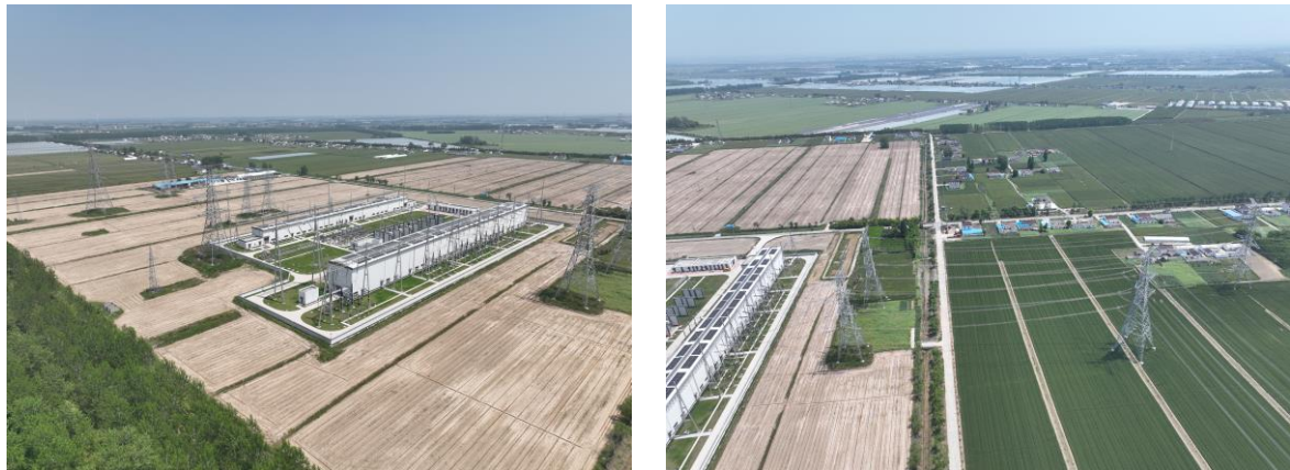
图 3.1-1 鹿乡（丰海）500kV 变电站扩建工程周边环境现状
