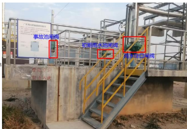
图3.8-1 厂区雨污切换原理和现状图
