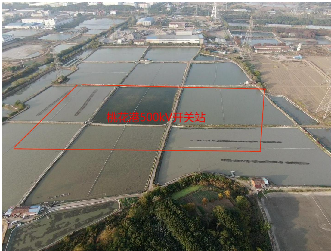
图3.1 桃花港500kV开关站周围环境现状
