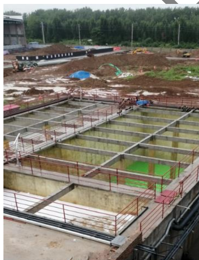
调节池、清水池、污泥池
