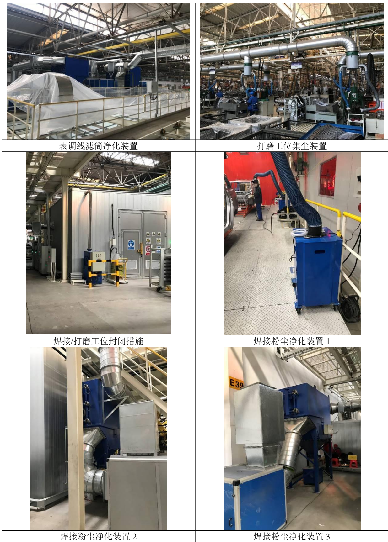
图 3.7-6 车身车间废气的污染防治措施现场照片
