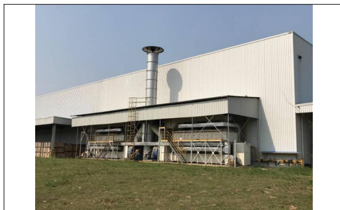
图 3.7-13 喷漆室及流平室废气污染防治现场照片
