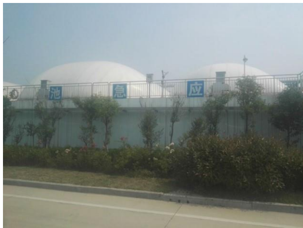
图 3.5-6 北区污水处理厂事故应急池
